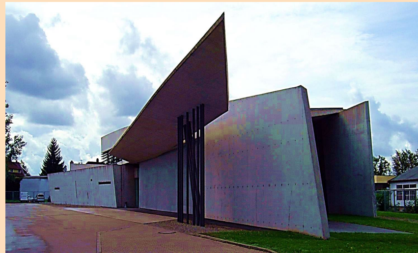
Заха Хадид. Пожарное депо компании «Витра» в Вейл-Рейне 1993г.
